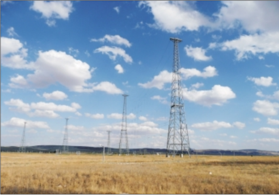
Antennen am TRT-Sendezentrum Emirler.
